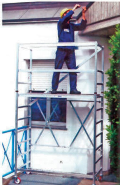
Con su achura de 1,20 m., se confiere una gran estabilidad. El sistema de regulación de tornillo sin fin, permite una regulación milimétrica de hasta 25 cm., sobre las ruedas, permitiendo compensar pendientes y desniveles sin influir en la estabilidad del andamio.
